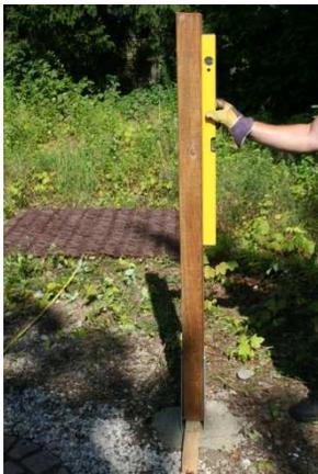
Bohren Sie mit Hilfe eines ausreichend großen Bohrers 4 Löcher vor und befestigen Sie den Pfosten mit Hilfe von Schloss-Schrauben an den Pfostenankern. Kontrollieren Sie vorsichtshalber mehrmals mit einer Wasserwaage, ob der Pfosten senkrecht steht.
