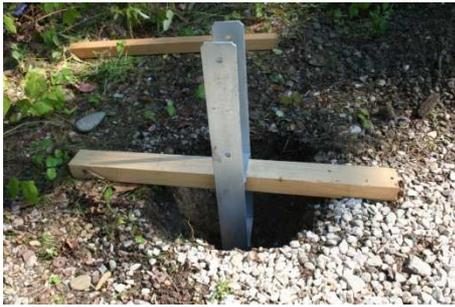
Rühren Sie aus Fertigbeton (Estrichbeton) und Wasser eine erdfeuchte Masse an und schütten Sie diese in das Loch. Glätten Sie die Oberfläche mit einer Maurerkelle und richten Sie den Pfostenanker mit Hilfe einer Wasserwaage aus.
