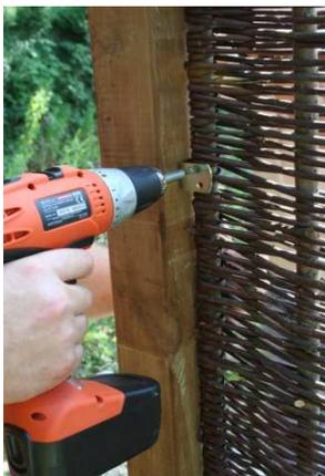
Die Zäune werden mit Hilfe von Flechtzaun- bzw. L-Winkeln an den Pfosten befestigt. Bei 1,5 und 1,8 Meter hohen Zäunen benötigen Sie pro Seite 3 Winkel, bei niedrigeren Zäunen reichen 2 Winkel pro Seite. Sie benötigen pro Winkel 2 Spax-Schrauben.
