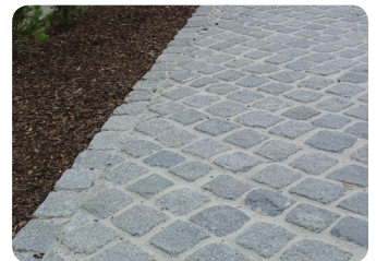
Fertig verfugte Fläche
